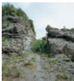
Tratto in trincea dell'antica linea ferroviaria.
